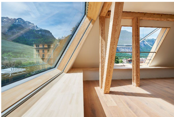
Nahtlos und dezent integriert sich das grossflächige Dachfenster s: 211 in die Gebäudehülle. Es kommt ohne vorstehenden Rahmen oder Aufbauten aus, lediglich ein schmaler Aluminiumrahmen trägt die Scheibe innen. Ziegel oder Dachpfannen überdecken den Markisenkasten der Beschattung vollflächig.
