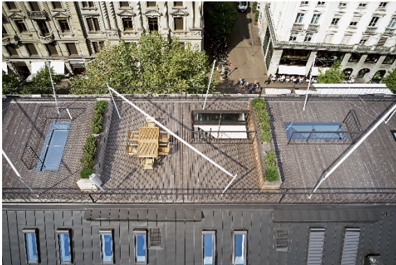
Der Dachausstieg s: 211 DA von s: stebler schliesst dank der verdeckten Flügelprofile bündig mit dem Terrassenboden ab.
